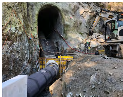
Druckleitungsbau
