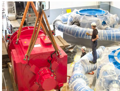
Einbau der Generatoren M1 und M2
